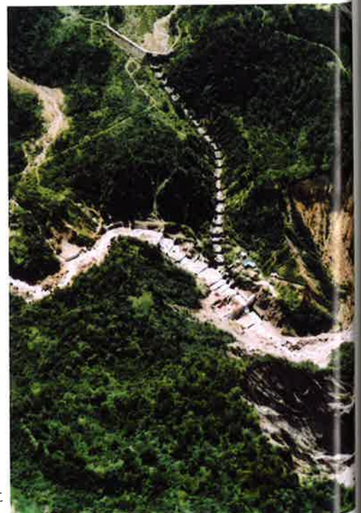
標高差122m、延長467mの急斜面に施工された砂防えん堤群
