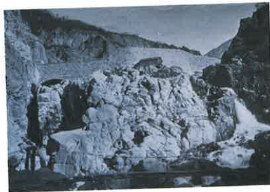
常願寺川上流・湯川に築造された白岩第一号堰堤 (富山県) (大正5年)
