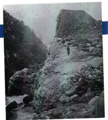
大正11年7月の豪雨による土石流で壊滅的な被害を受けた白岩第一号堰堤 (富山県)
