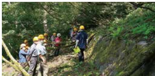
明治～大正の県営砂防時代につくられた金山谷山腹工(砂防バスコース)
