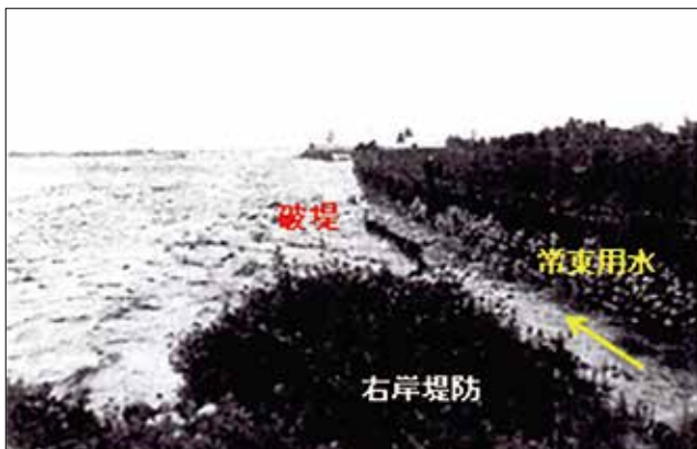
立山町三ツ塚新地内の堤防破堤状況 堤防破堤で洪水が常東用水用水に奔流する様子 （『富山工事事務所六十年史記録写真集』より）
