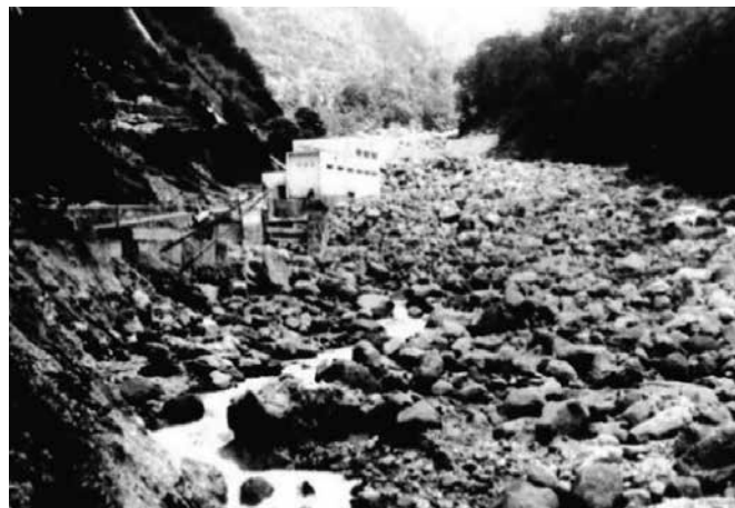
土石に埋もれる称名川第2発電所 立山町称名川 （『水害写真集 流の記録』より）
