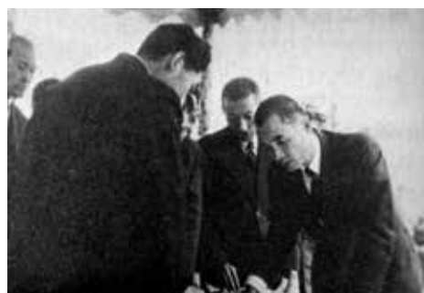
昭和25年、高松宮殿下に常願寺川改修とタワーエクスカベーターについて説明する橋本規明 （『常願寺川の急流河川工法』1980年より）
