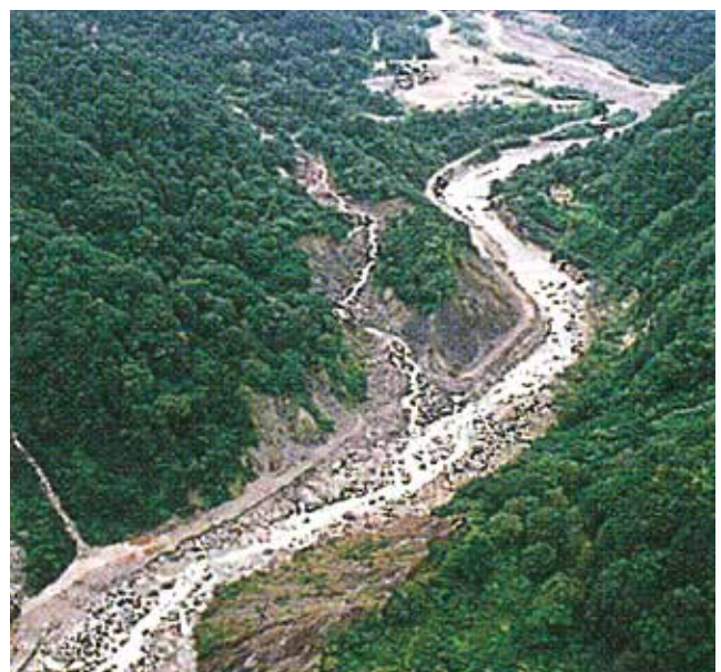
工事用道路を遮断した土石流(真川スゴ谷合流点付近、平成10年8月12日)
