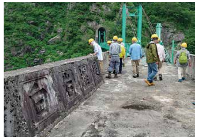
白岩堰堤砂防施設
