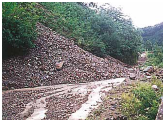
土砂崩れで遮断された工事用道路 (立山カルデラ白岩堰堤付近)
