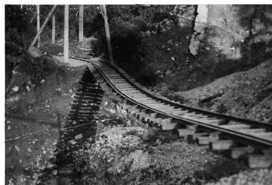
破壊された線路
