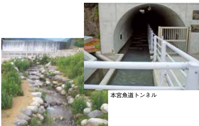
「魚道」せせらぎ水路 魚が堰堤の上・下流へ移動できるように工夫されています。
