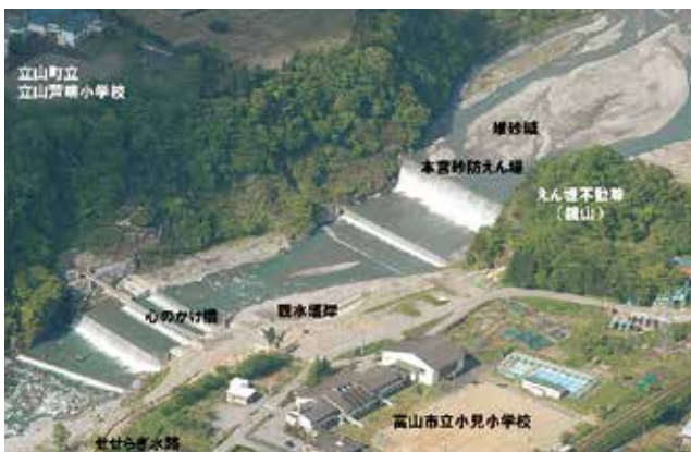
上空から見た本宮堰堤 水辺に近づきやすいように設けられた「親水護岸」、魚が住みやすいように整備された「せせらぎ水路」など、年間を通して体験できるように整備されています。
