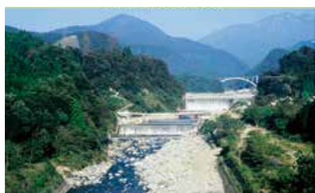
本宮砂防堰堤
