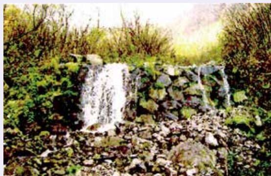
現存している県営砂防施設
