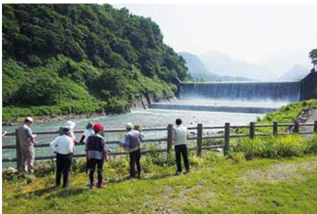
本宮砂防えん堤
