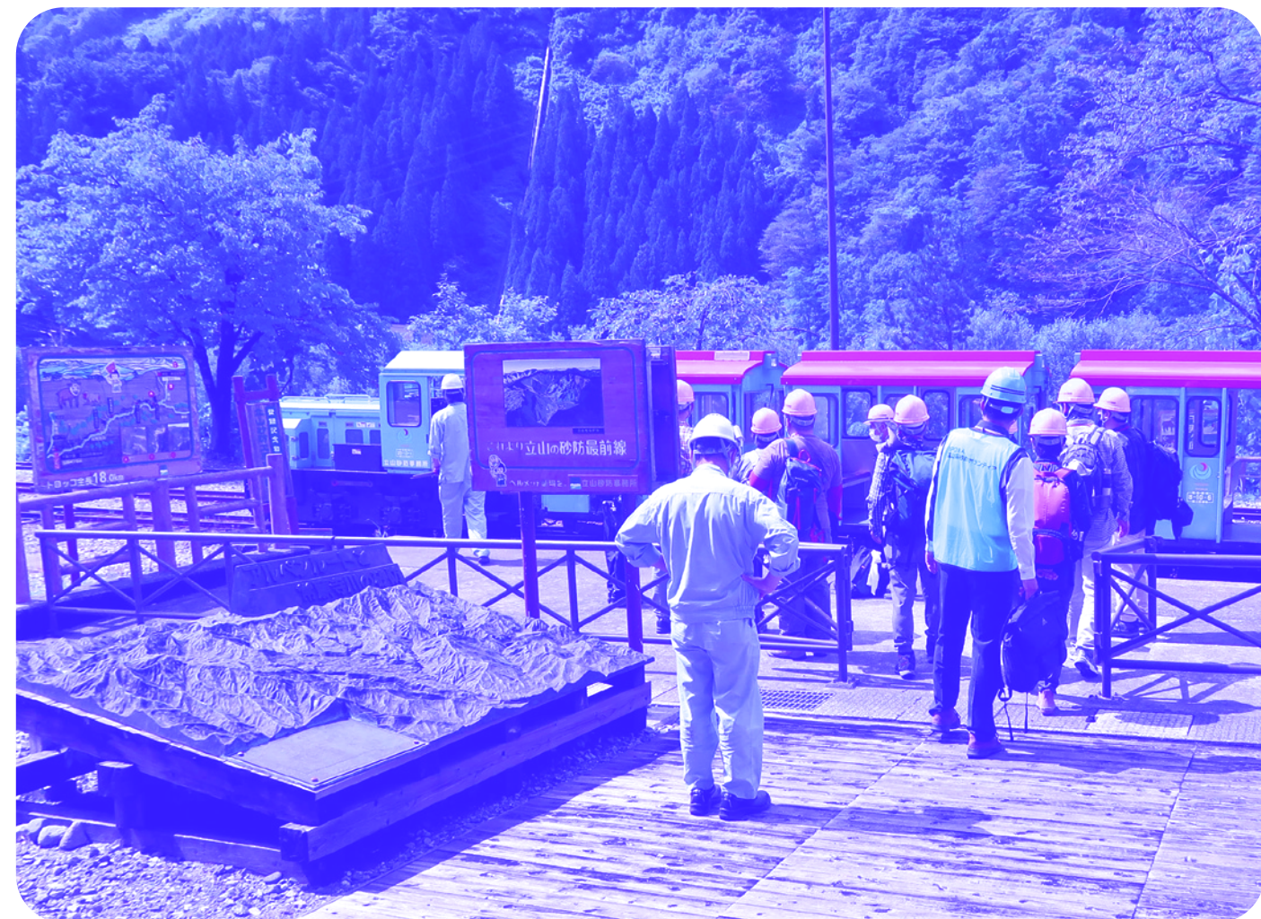
立山砂防工事専用軌道(トロック)
