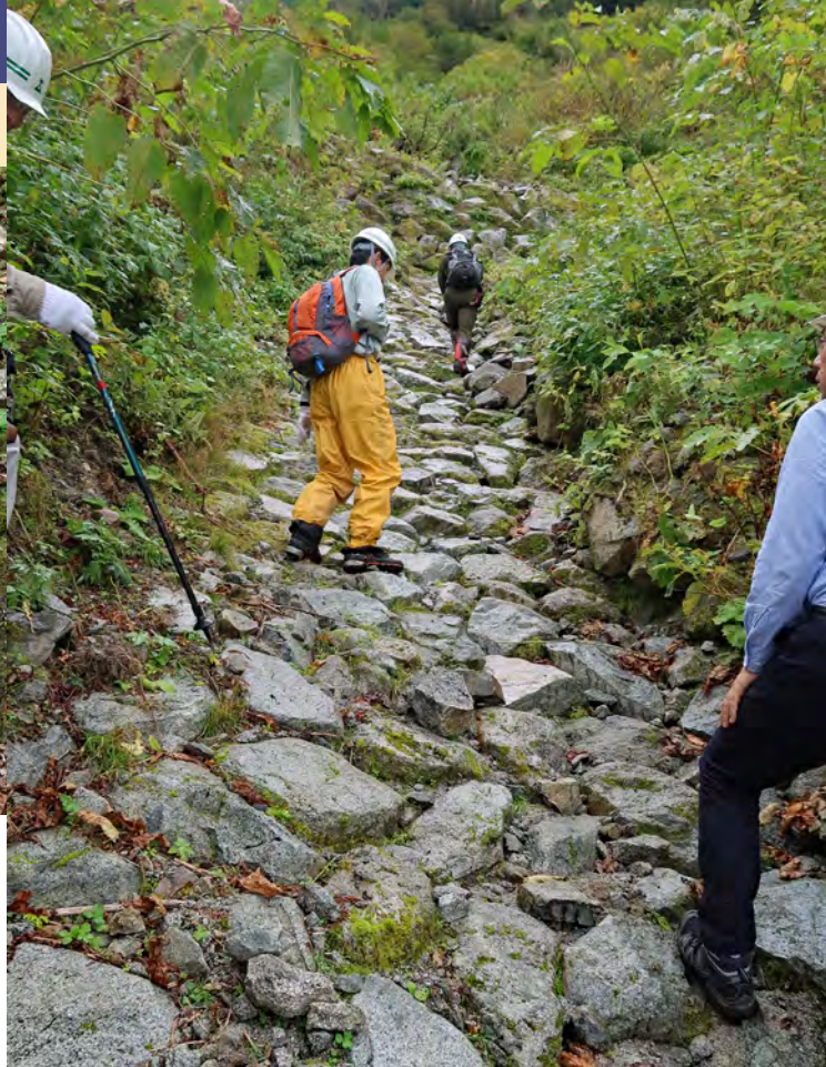
西五ノ谷の水路石張工と石積みえん堤
