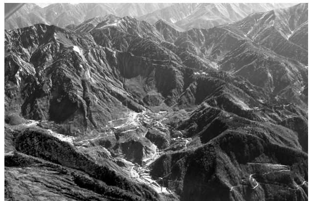
図-4 北側上空から俯瞰した多枝原凹地(2013年10月、井口隆撮影)。中央左寄り上部の凹地が大鳶崩れの発生源であり、その右側の窪みは多枝原池の凹地
