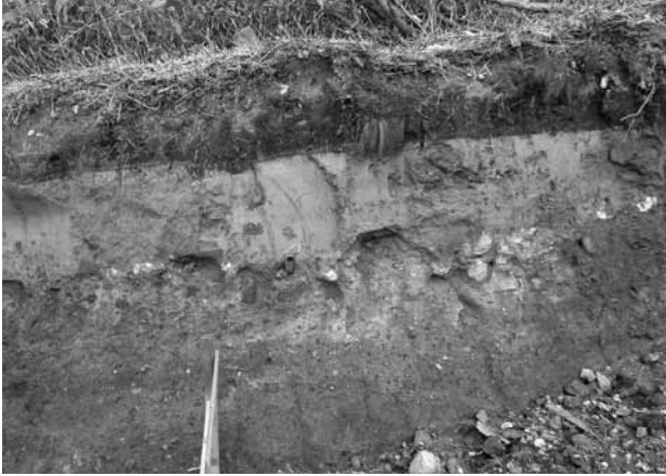
写真-1 地質スケッチ箇所の地層断面
