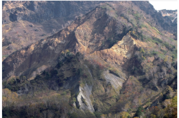
写真16 湯川谷左岸高標高部の硫気変質と崩壊跡
