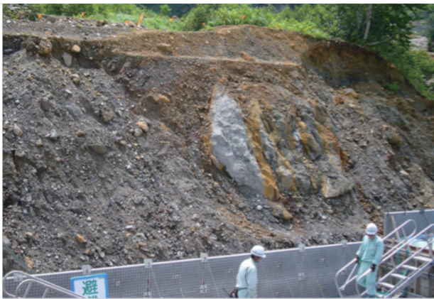
写真3 多枝原谷第28号砂防堰堤建設中に観察された鳶泥の断面
