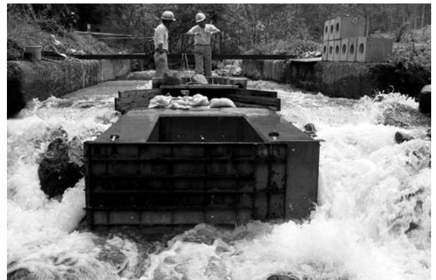
写真16 砂礫の除去と水中加重計の点検後のピット（ピットのカバー前の状況）
