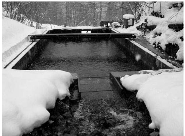
写真11 ヒル谷試験堰堤の貯水池
