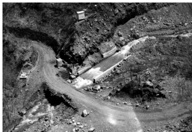
写真-30 足洗谷観測水路付近の状況
