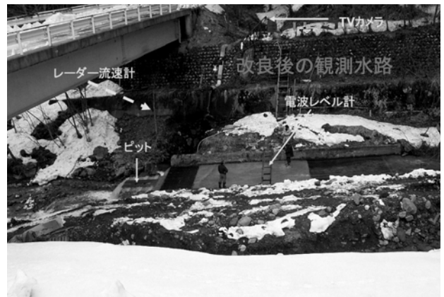
写真-36 改良後の足洗谷観測水路
