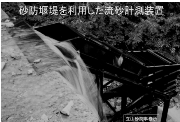
写真-39 砂防堰堤を利用した流砂計測装置
