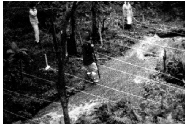
写真-28 試験堰堤下流の河床測量
