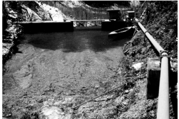
写真-18 溪流出口の試験堰堤
