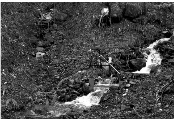
写真-16 土砂流出が発生する溪流（ヒル谷支流合流部）
