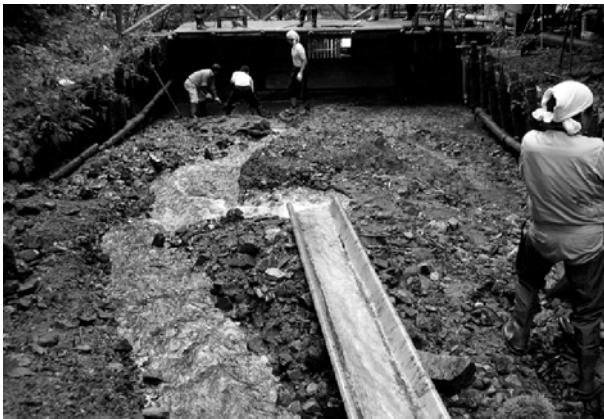
写真-26 試験堰堤のゲートからの土砂出し
