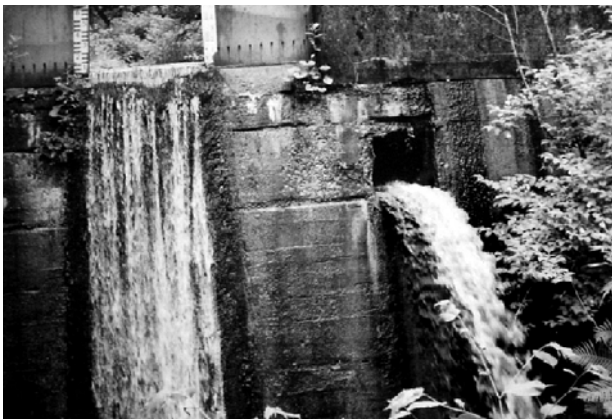
写真-27 試験堰堤の暗渠からの土砂出し
