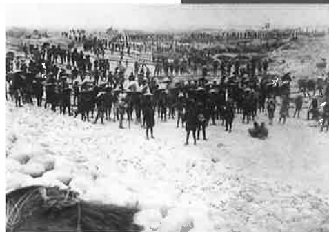
明治24年 常願寺川改修工事
