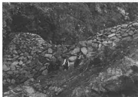
大正12年 富山県による砂防工事(西三ノ谷第十五号堰堤) 立山砂防事務所 所蔵
