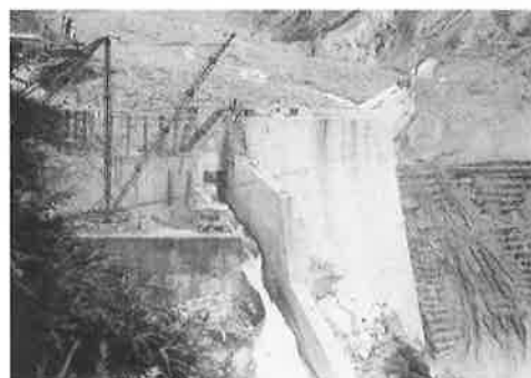
昭和12年 国による砂防工事 (白岩堰堤左岸袖部第一導水堤継ぎ混泥土工事及び堰堤全影) 立山砂防事務所 所蔵
