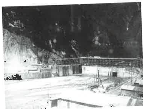
右岸上流高所より えん堤箇所全望と運搬栈橋 7月7日
