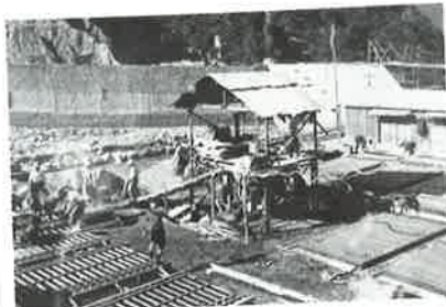
護岸コンクリート枠柱製作
