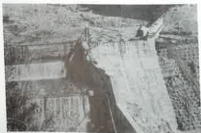
白岩砂防えん堤通水の状況 11月6日
