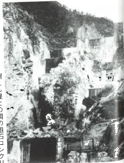
3号隧道横口より えん堤水路部張石工事状況 7月21日
