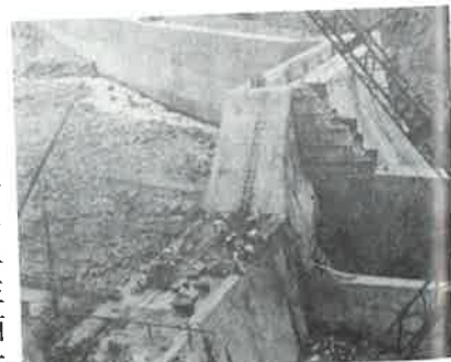
3号隧道横口より えん堤水路部張石工事状況 7月21日
