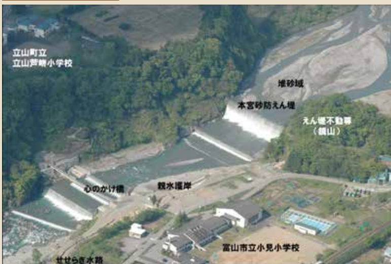
上空から見た本宮砂防堰堤
