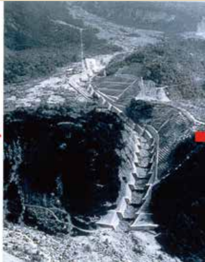
1933（昭和8）年 階段式砂防堰堤と山腹工を組み合 わせた砂防工事が行われました。
