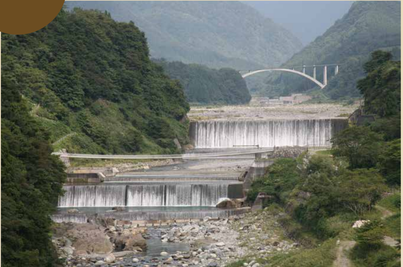
本宮砂防堰堤
