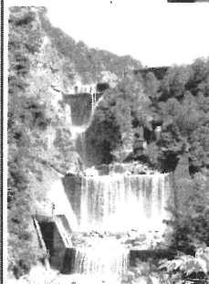
富山県が築いた黒川第1号堰
