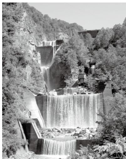
白岩堰堤(国指定重要文化財)
