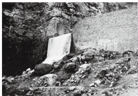
富山県が施行した湯川第1号堰堤
